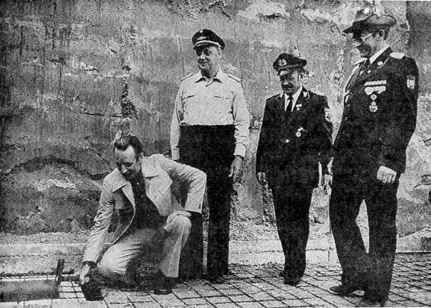
NEIMAL KLOPFTE Colnrades Bürgermeister Werner Helms nach alter Tradition auf den Grundstein, der am Mittwochabend für das neue Feuerwehrgerätehaus und den unterirdischen Schießstand gelegt wurde. Neben
