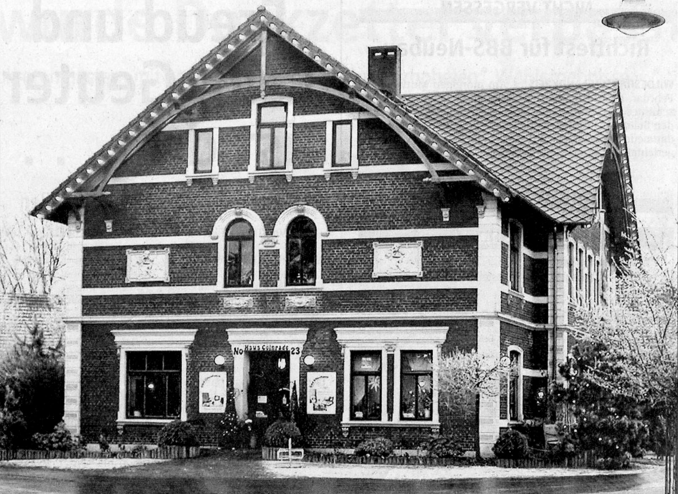
Die stilvollen Fassaden des „Stammhauses“: An beiden Giebeln zur Straßenseite hat man die ursprünglichen Zierbögen hergestellt. Abendlich werden die Giebel von einem Lichterband eingrahmt. Foto: privat
