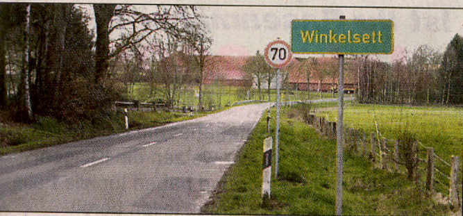
An der Straße nach Harpstedt wird bald ein Radweg gebaut.
