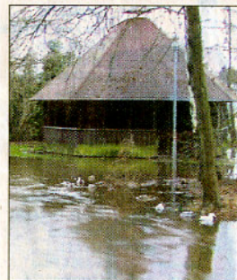
Vom Wasser umgeben: die Grillhütte in Harpstedt.
