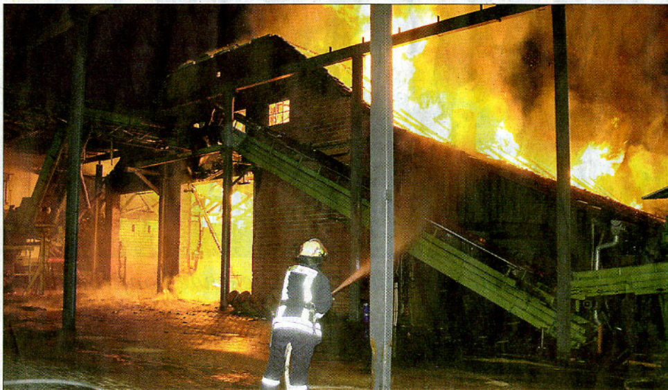
Beim Eintreffen der ersten Feuerwehrräfte hatten sich die Flammen bereits durch das Dach gefressen.
