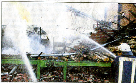
Die Lager- und Produktionshalle wurde ein Raub der Flammen. Auch drei Gabelstapler verbrannten. Foto: boh
