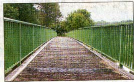
Neue Holzbohlen bekommt die Radbrücke.
