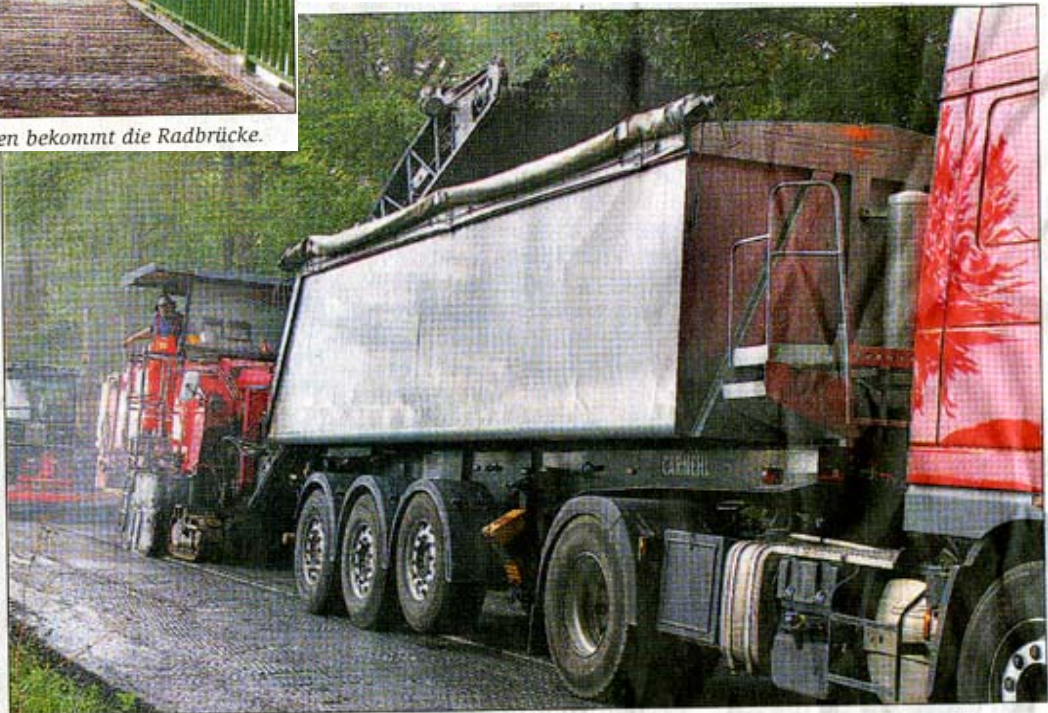
Der Asphaltboden wird in Sekundenschnelle abgefräst.
