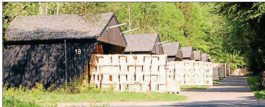
In dem ehemaligen Muna-Gelände stehen riesige Kistenstapel nahe des grünen Waldgürtels. Ist hier dem vorbeugenden Brandschutz genüge getan, fragt sich Altlandrat Hermann Bokelmann.
