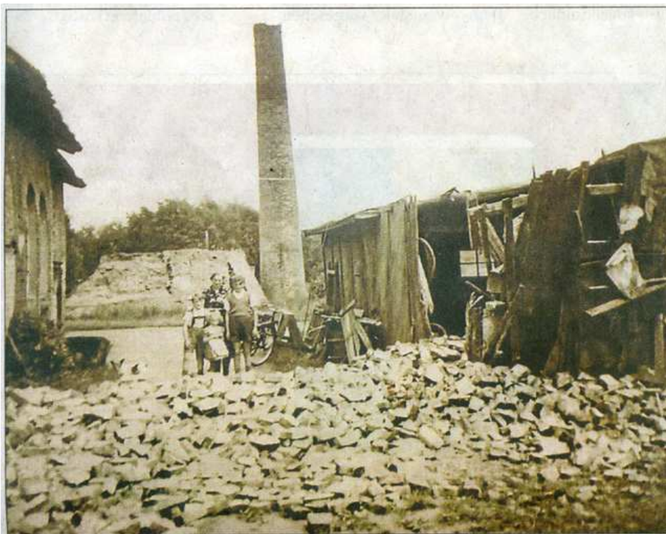
Das Ende der Ziegelei: Der Abriss hat begonnen. • Foto: Privatbesitz von Hans Meinke
