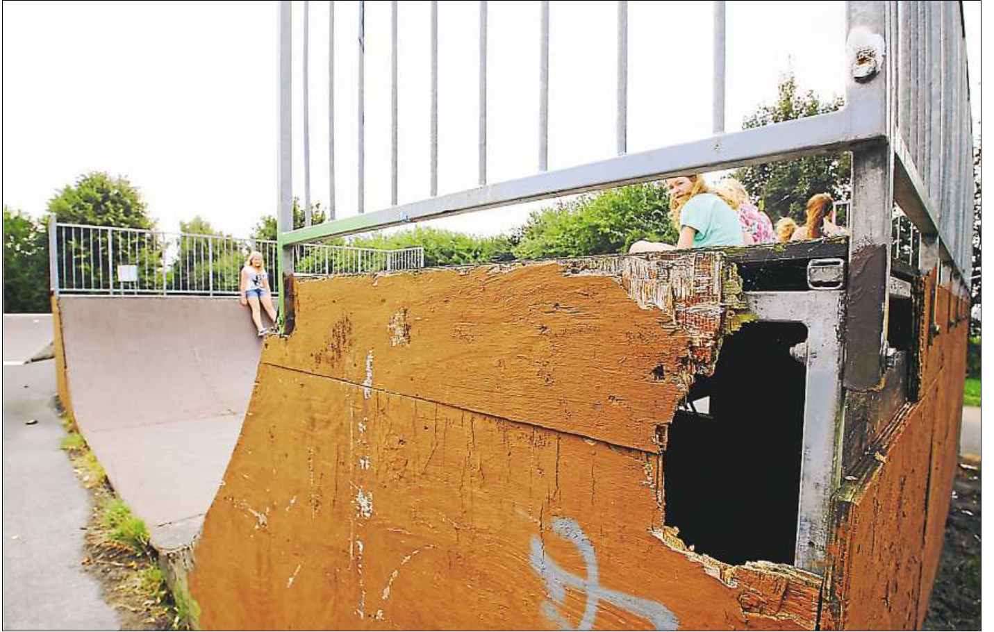
Zerstörungswut: Die Außenverkleidungen der Bahnen auf der Skateranlage in Harpstedt sind teilweise löcherig. Die Bahnen selbst sollen einen widerstandsfähigeren Belag bekommen.
