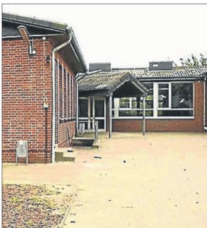
Auch aus energetischen Gründen hat der Samtgemeindeausschuss eine „Kröte“ geschluckt: Das Dach des bisherigen Grundschulgebäudes in Dünsen wird größtenteils erneuert. ■ Archivfoto: Bohlken
