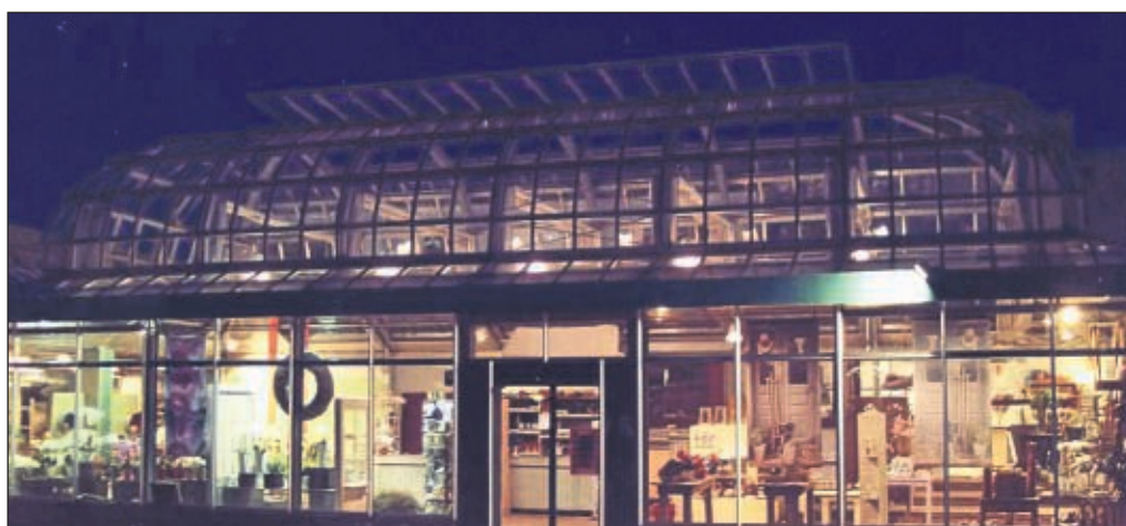
Dieses höchst ungewöhnliche Glashaus mit wirklich extravaganter Dachkonstruktion soll im Oktober im Essgarten in Barjenbruch neu aufgebaut werden.
