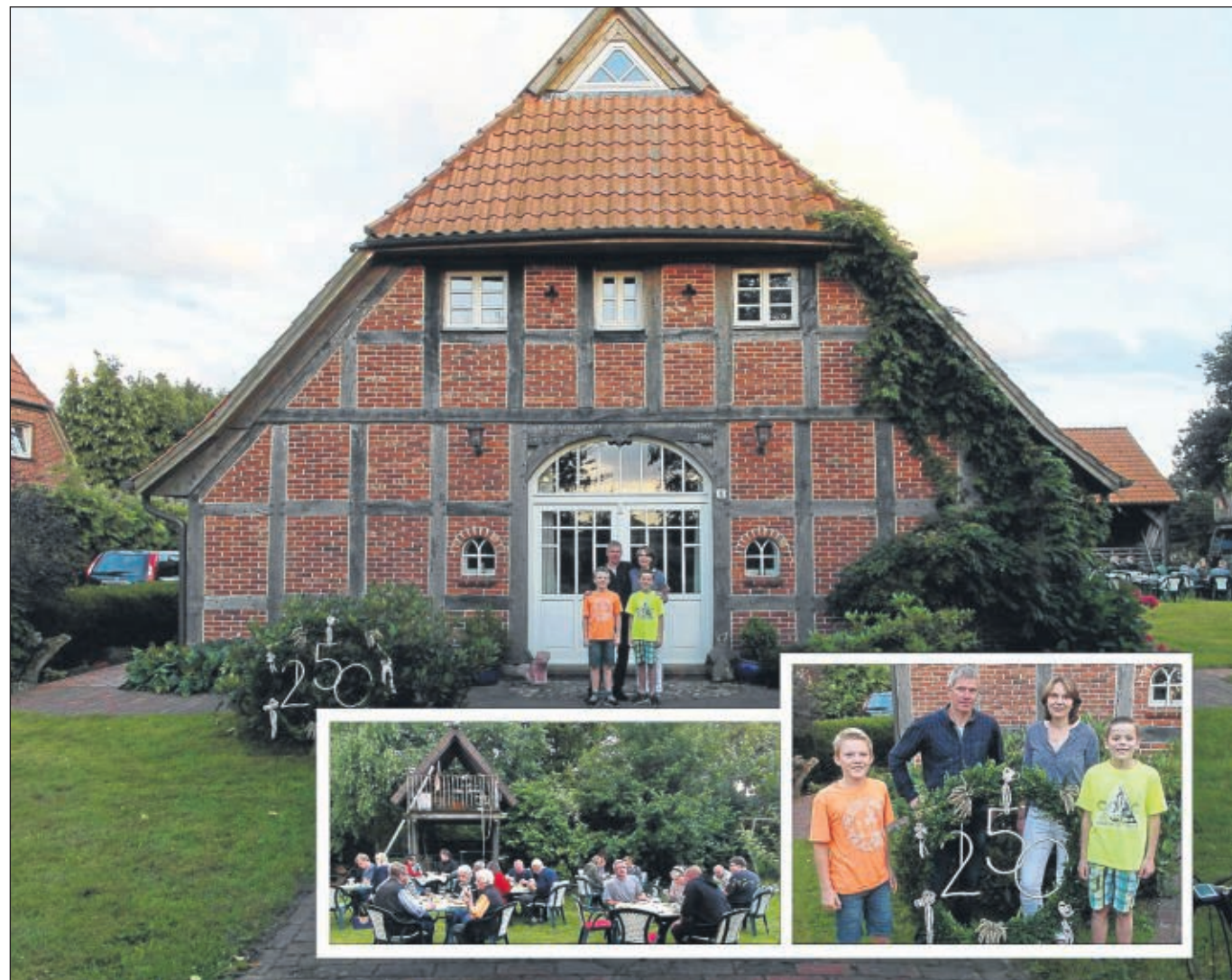
Anlässlich der Erbauung des Fachwerkhäuses vor 250 Jahren lud die Familie Meyer-Schrage zahlreiche Helfer zu sich nach Beckstedt ein, die vor 16 Jahren am Abbau des Gebäudes und danach am Wiederaufbau mitgewirkt hatten. Kleines Bild rechts: Stephan Meyer-Schrage und seine Frau Petra mit den Söhnen Theo (links) und Tjark (rechts).
