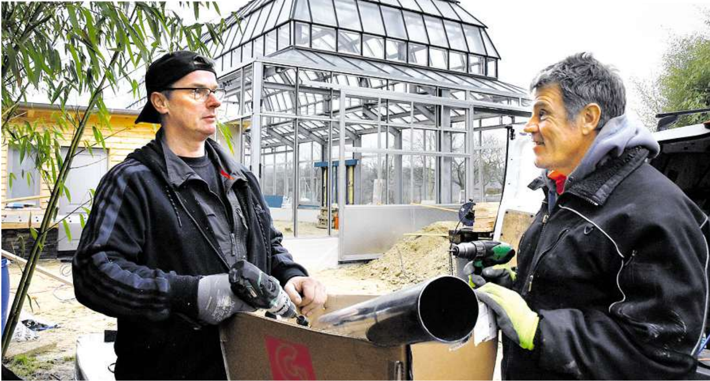
Der imposante „Kristallpalast“, noch eine Baustelle, ragt 6,53 Meter in die Höhe. Rechts im Bild Frits Deemter.
