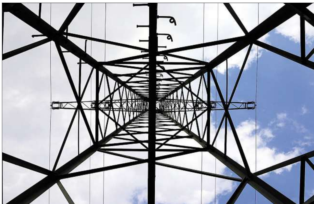
Noch führt eine 110-kV-Leitung von Ganderkesee nach Süden. Jetzt kann die 380kV-Trasse gebaut werden – die Masten der Freileitung werden rund 60 Meter hoch sein, BILD: HERGEN SCHELLING
