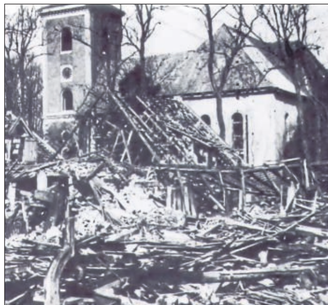
Die Fenster der Kirche mussten nach dem Angriff zunächst notdürftig mit Brettern vernagelt werden. • Archivfoto.
