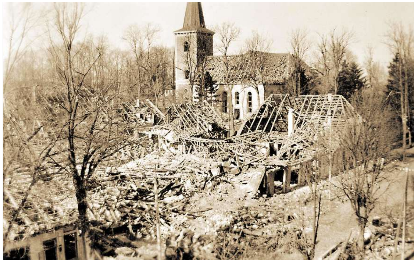
Ein Bild der Zerstörung: Viele Häuser wurden bei dem Luftangriff beschädigt, einige dem Erdboden gleichgemacht. Das Foto zeigt die Umgebung der Harpstedter Christuskirche, vorn rechts die Grüne Straße.
