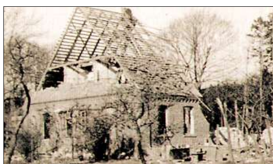
In diesem zerbombten Haus in Dünsen überlebte das Ehepaar Dannemann – wie durch ein Wunder.
