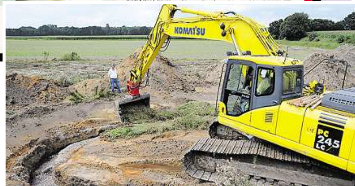
Beckstedter Bach schlägt jetzt Bögen: Im August 2017 wurde das neue Bett ausgebaggert.
