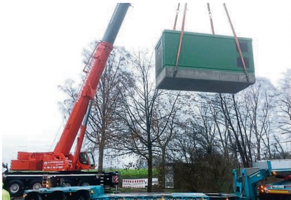
Mithilfe eines Krans wird die neue Schaltstation an den dafür vorgesehenen Standort in Beckstedt bugsiert (rechts die alte).
