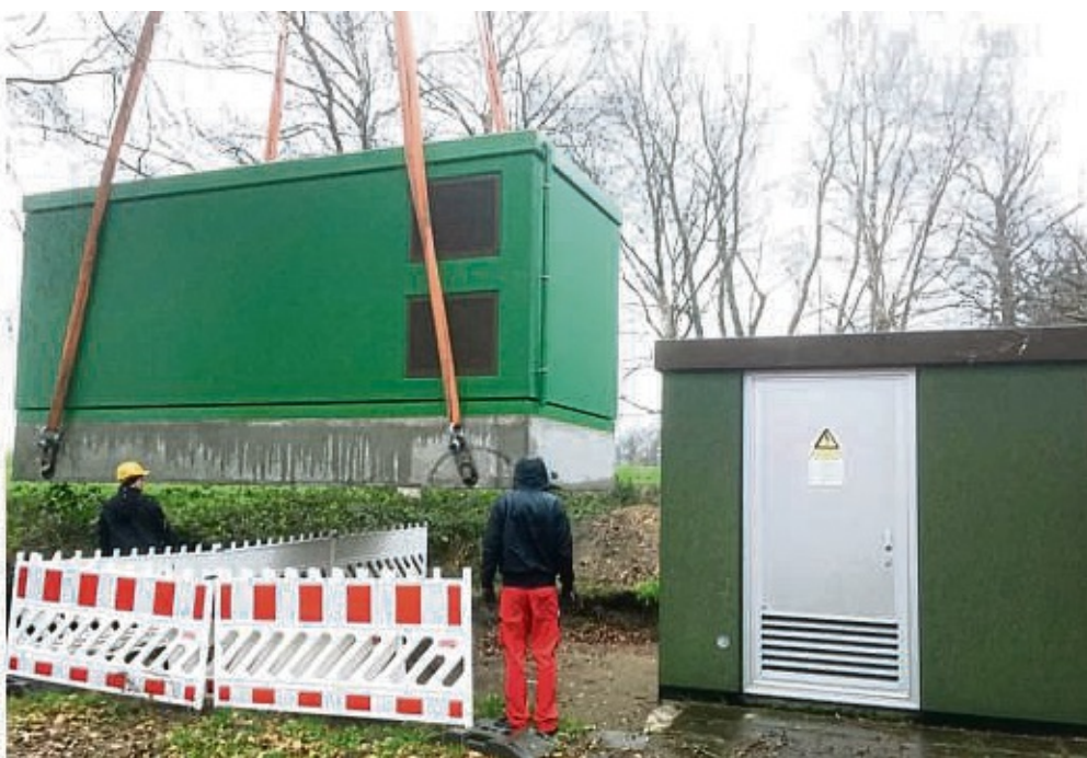
Mithilfe eines Krans wird die neue Schaltstation an den dafür vorgesehenen Standort in Beckstedt bugsiert (rechts die alte).
