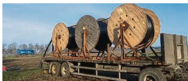
Der Trommelwagen, von dem die Kabel durch die Autobahnbohrung gezogen wurden.
