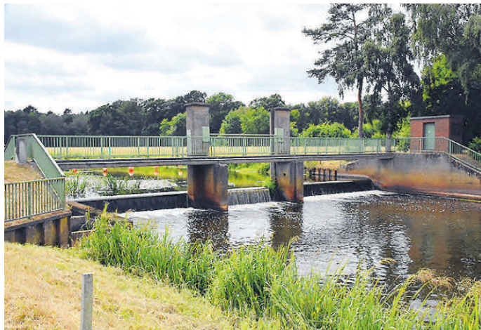
Wird seine bisherige Funktion verlieren: das Stauwerk nördlich der Ortschaft Colnrade
