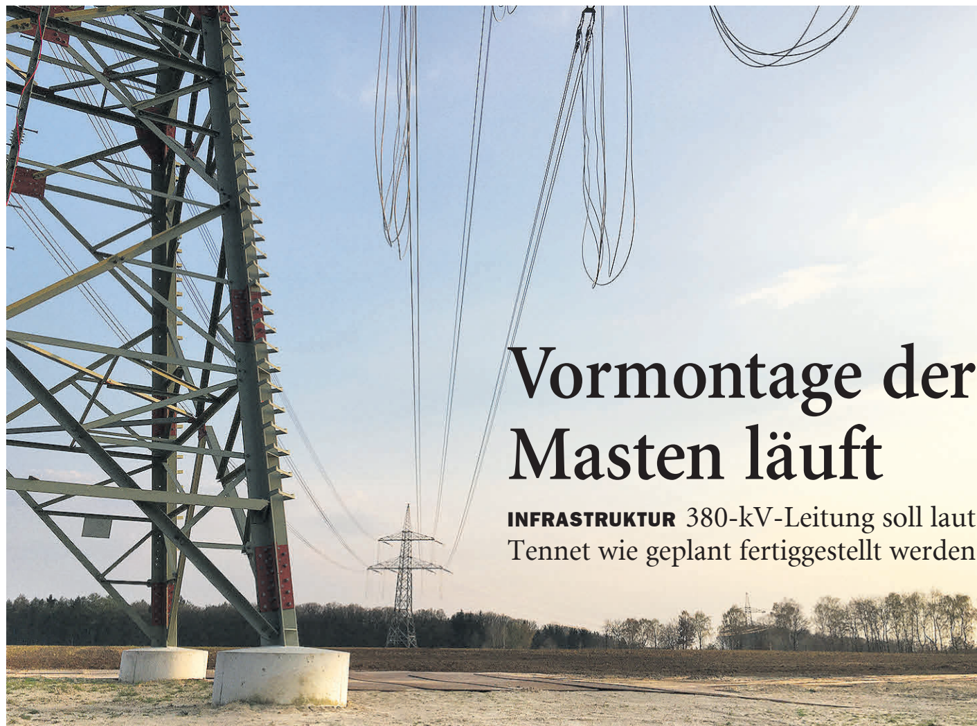
Die Arbeiten gehen voran: Die ersten Strommasten – hier in Wohlde – sind bereits verbunden.
