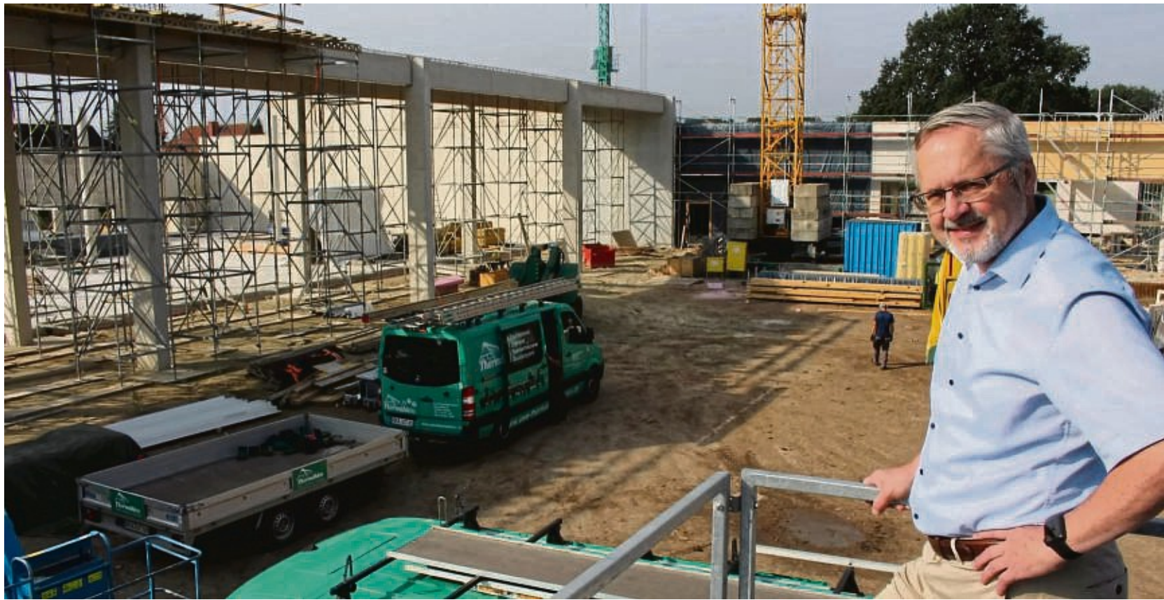
Inkoop-Geschäftsführer Bernd Oetken ist mit dem Stand der Bauarbeiten zufrieden.
