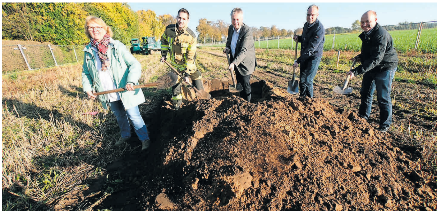
Freuen sich über den Baubeginn der neuen Feuerwehr: Anne Wilkens-Lindemann (v.l.), Marvin Hartje von der Feuerwehr Colnrade, Samtgemeindegemeister Herwig Wöbse sowie Jens Hüfner und Bernd Siemers (Bauamt). BILDER: TORSTEN VON REEKEN
