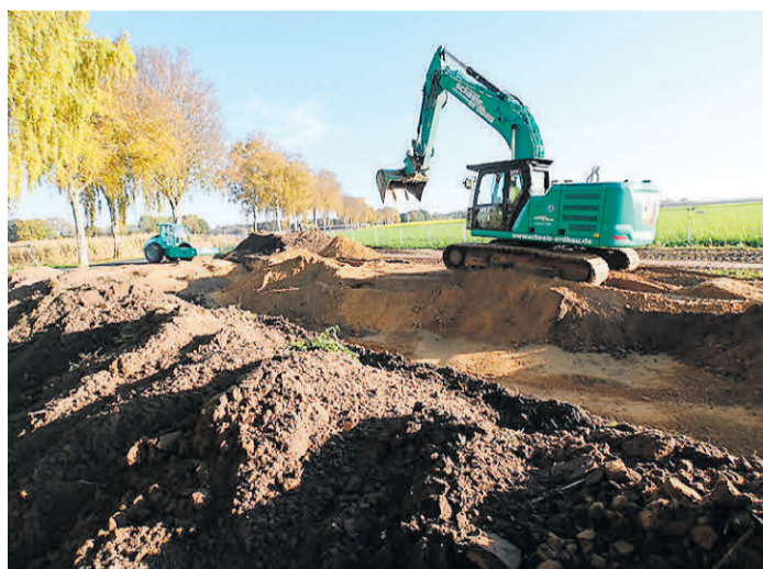
Es geht los: Die Erdarbeiten laufen seit einigen Tagen.
