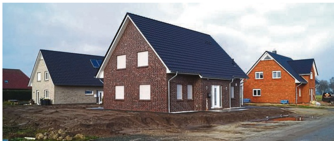
Einige Häuser im Colnrader Neubaugebiet sind schon fertiggestellt oder sogar bereits bewohnt.
