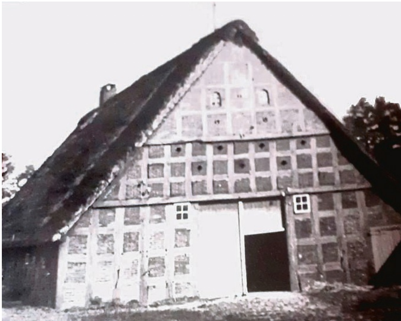
Das Haus Dahms: Im Zuge von Abrissarbeiten wurde hier der Beckstedter Sonnenstein entdeckt.
