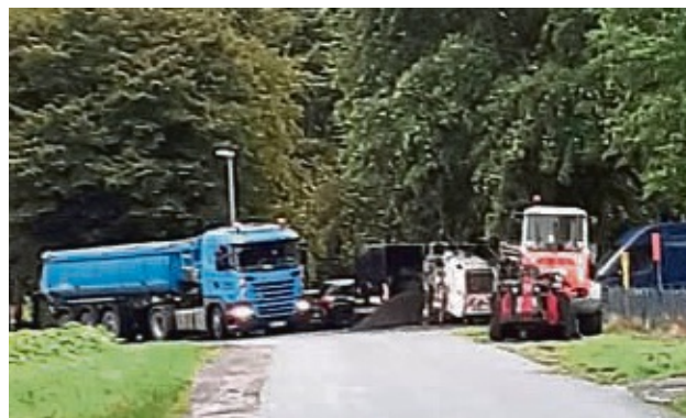
Welche Maßnahme ist angebracht und zielführend, um Straßenschäden zu beheben? Vor dieser Frage stand jüngst auch der Kirchseelter Rat. Fast 70 000 Euro lässt sich die Gemeinde die Sanierung des kurzen Weges „Im Grünen Winkel“ in Klosterseele kosten. Die Arbeiten haben dieser Tage begonnen.
