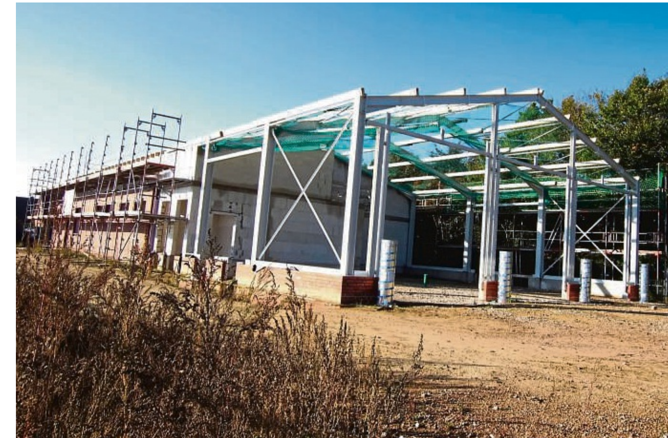
Der Feuerwehrhausneubau könnte in Kürze gerichtet werden. Ein Richtfest ist aber nicht vorgesehen.
