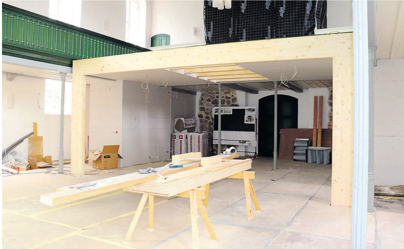
Es entsteht ein „Raum im Raum“: Nach dem Umbau der Kirche in Colnrade ist dieser durch eine Glaswand abgetrennt und kann separat genutzt werden. BILD: JANA BUDE
