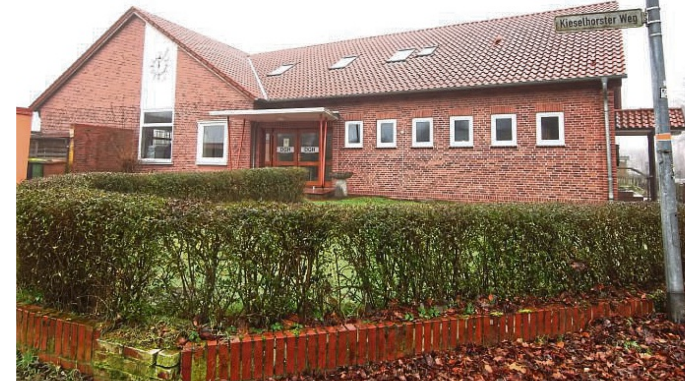
Mit einem Mittelbedarf von rund 207 000 Euro für das Dorfgemeinschaftshaus rechnet die Gemeinde.
