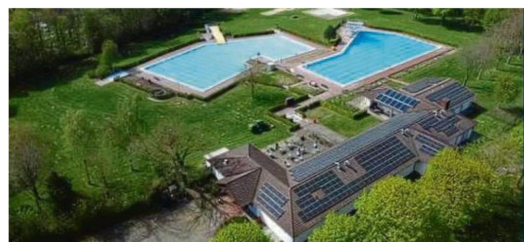
Die Fotovoltaikanlage ist seit Juni 2022 auf dem Dach des Harpstedter Freibades. FOTO: MANNECK
