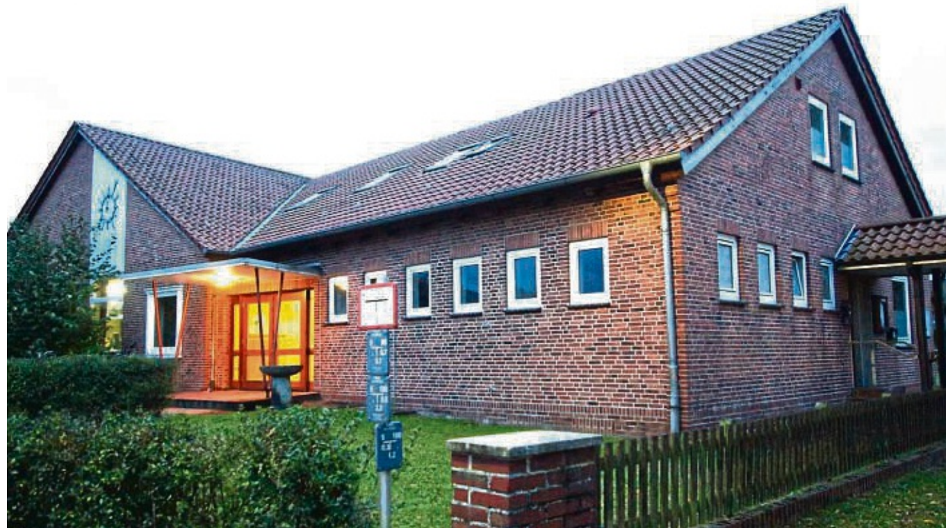
Nur mithilfe erheblicher „Leader“-Mittel kann es sich die Gemeinde leisten, rund 200 000 Euro ins Dorfgemeinschaftshaus zu investieren. Das geschnürte Maßnahmenpaket soll von Februar bis Anfang Juli 2024 abgearbeitet werden. FOTO: BOHLKEN
