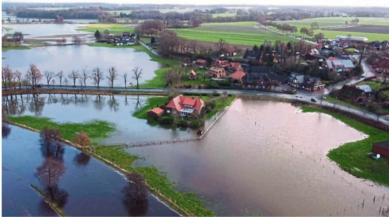
Das Haus des früheren stellvertretenden Colnrader Bürgermeisters Wolfgang Brand (in der Bildmitte gut zu erkennen) ist wegen seiner Lage bei Hochwasser besonders gefährdet. FOTO: NORD-WEST-MEDIA-TV
