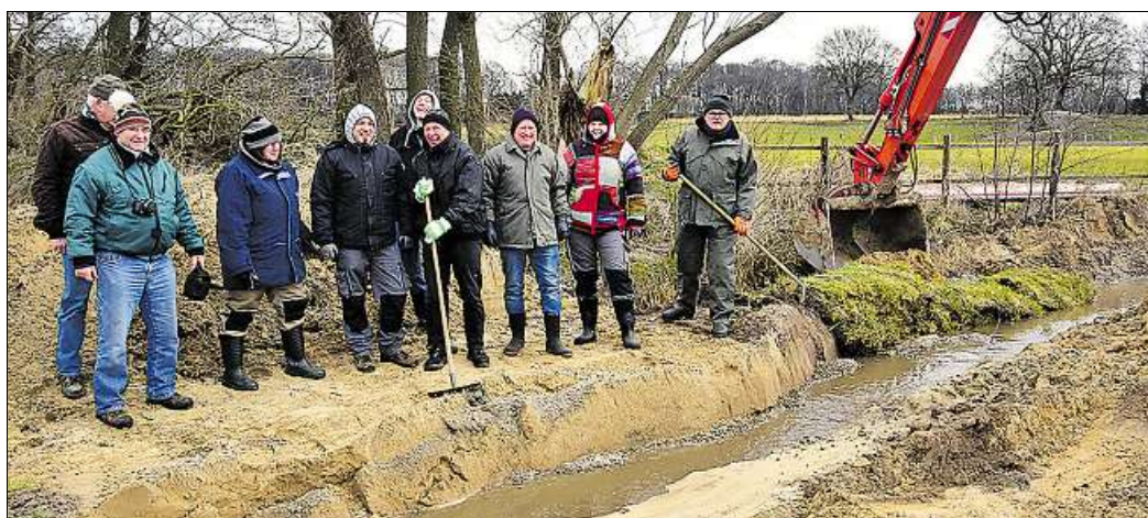
Geschafft: Seit dem Wochenende fließt der Beckstedter Bach in seinem neuen, mäandrierenden Bett. Ziel ist die Revitalisierung des Gewässers. BILD: PETER KRATZMANN
